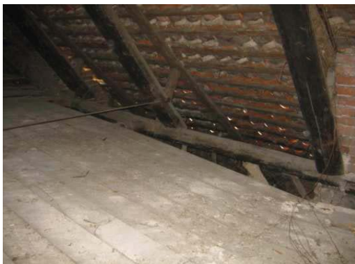
Abb. 32: übermäßige Bauteilverformungen
