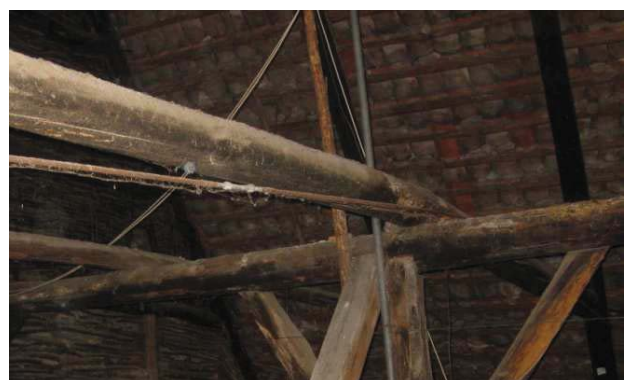
Abb. 32: übermäßige Bauteilverformungen
